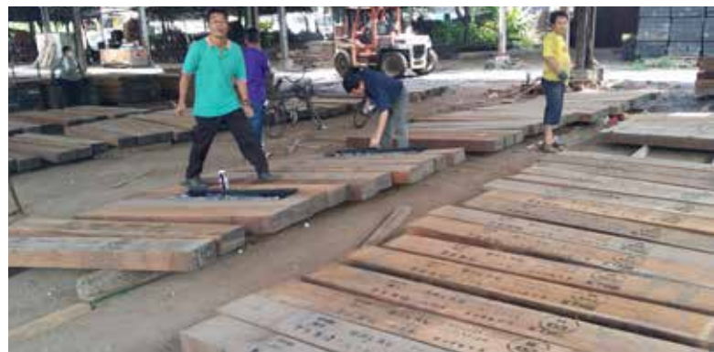
Kerja-kerja mengecat slot stensil ke atas kepingan selepas selesai kerja-kerja pemeringkatan
