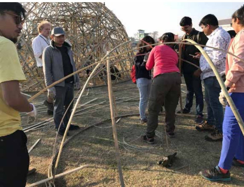
Pemasangan rangka bangunan
