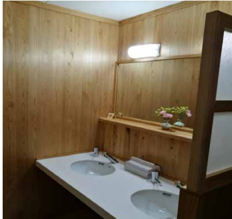
Panel Oil palm Plywood dengan Sugi veneer sebagai bahan binaan yang diaplikasikan dalam projek pembinaan hotel
