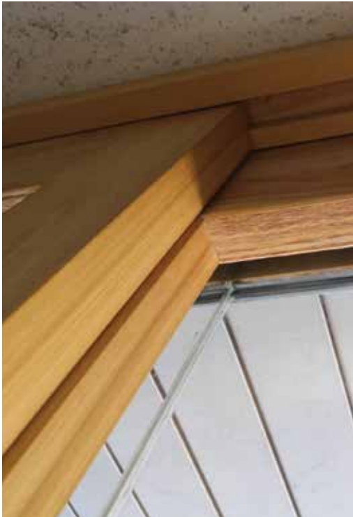
Bingkai tingkat yang dibuat dari OPT plywood dengan Sugi veneer sebagai permukaan terletak di Hotel Gero
