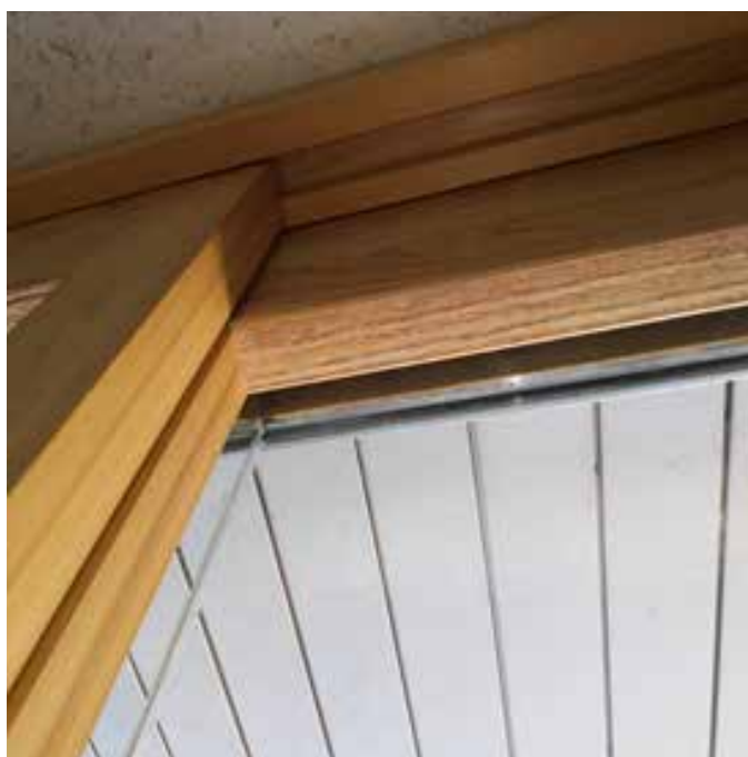
Panel Papan Lapis OPT dengan Sugi Venir sebagai Bahan Binaan yang diaplikasikan dalam Projek Pembinaan Hotel di Jepun, Lawatan Teknikal Teknologi Pemprosesan Papan Lapis OPT ke Jepun 21 – 28 Julai 2019
