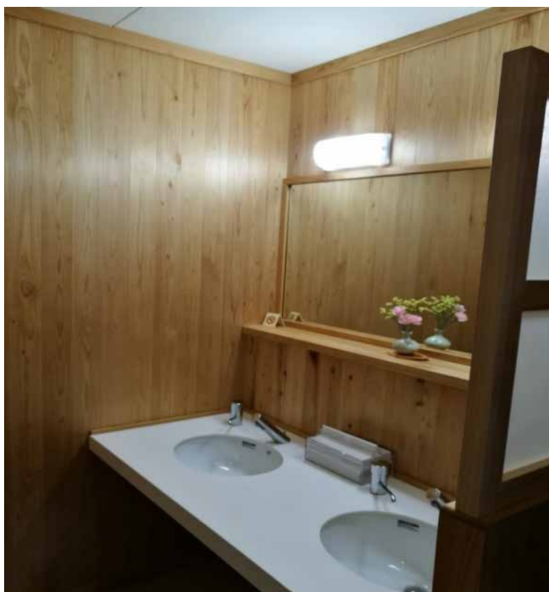
Panel Papan Lapis OPT dengan Sugi Venir sebagai Bahan Binaan yang diaplikasikan dalam Projek Pembinaan Hotel di Jepun, Lawatan Teknikal Teknologi Pemprosesan Papan Lapis OPT ke Jepun 21 – 28 Julai 2019
