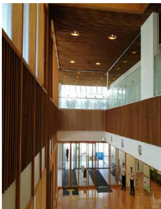
Sugi flooring yang digunakan oleh sekolah rendah dan Toyota City Hall di Inuyama dengan struktur Glulam
