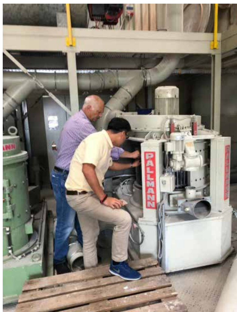
Mill Trails dan ujian kecekapan menggunakan mesin pulveriser di kilang
