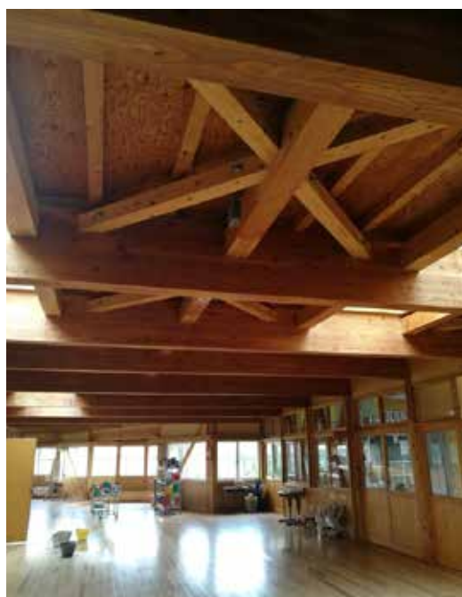
Sugi flooring yang digunakan oleh sekolah rendah dan Toyota City Hall di Inuyama dengan struktur Glulam
